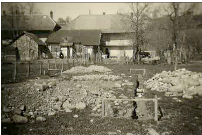
L'emplacement avant création de l'abris à charpente. (Archive)
